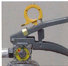
× 安全栓の抜けかけ
