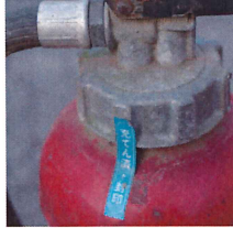
× キャップの劣化
